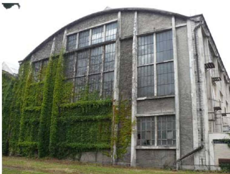
Fig. 7. La grande halle (source TRANS FAIRE, 2014)
